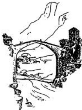
Este hermoso puente que se muestra fue construido por los romanos.
