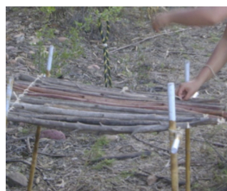
3. Fijar bien la base a la estructura; considerar que no queden grandes orificios entre los palos
